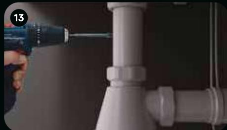
Используя сверло диаметром 8 мм, просверлите отверстие для врезки в канализацию на вертикальном участке сливной трубы между раковиной и сифоном.
